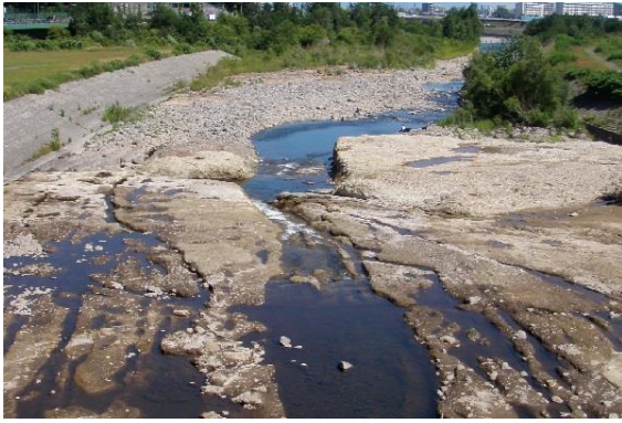
【図4】岩盤露出(さけ科学館横)
